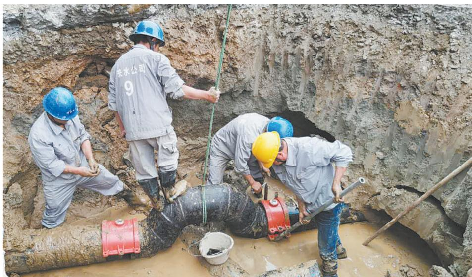
自来水公司工作人员在汽车南站北门抢修发生漏水的DN300给水管。
