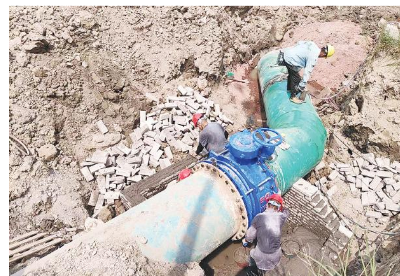
中意宁波生态园DN1000新建给水管四标段施工现场。
